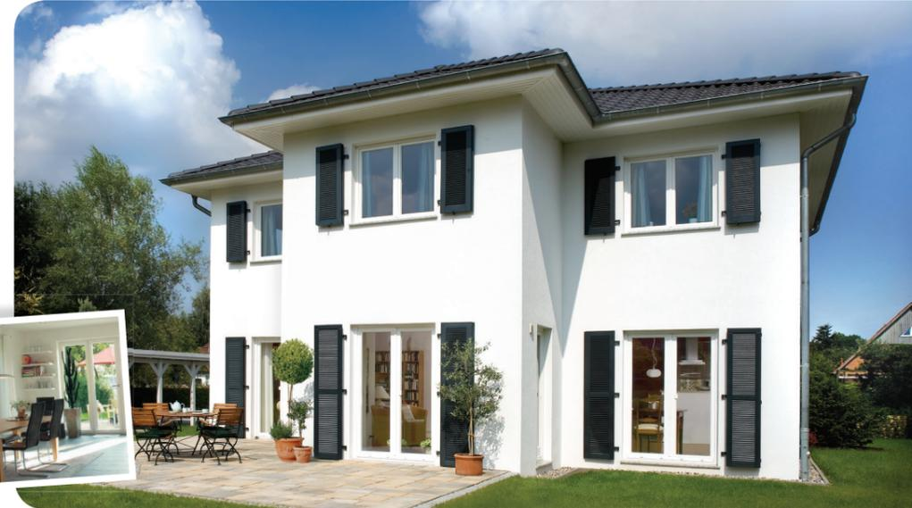
**Nachher:** Aus dem Haus ist nahezu eine mediterrane Villa geworden. Im Erdgeschoss wurden die kleinen Fenster komplett durch bodentiefe hochwärmgedämmte Fenstertüren mit einer GAYKOSafeGA Sicherheitsausstattung ersetzt. Ein neuer Anstrich und die Ergänzung aller Fenster mit harmonischen Klapppläden verleihen dem Haus zusätzliches Flair.
